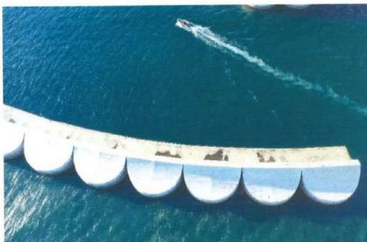
南防波堤俯拍实景照片
