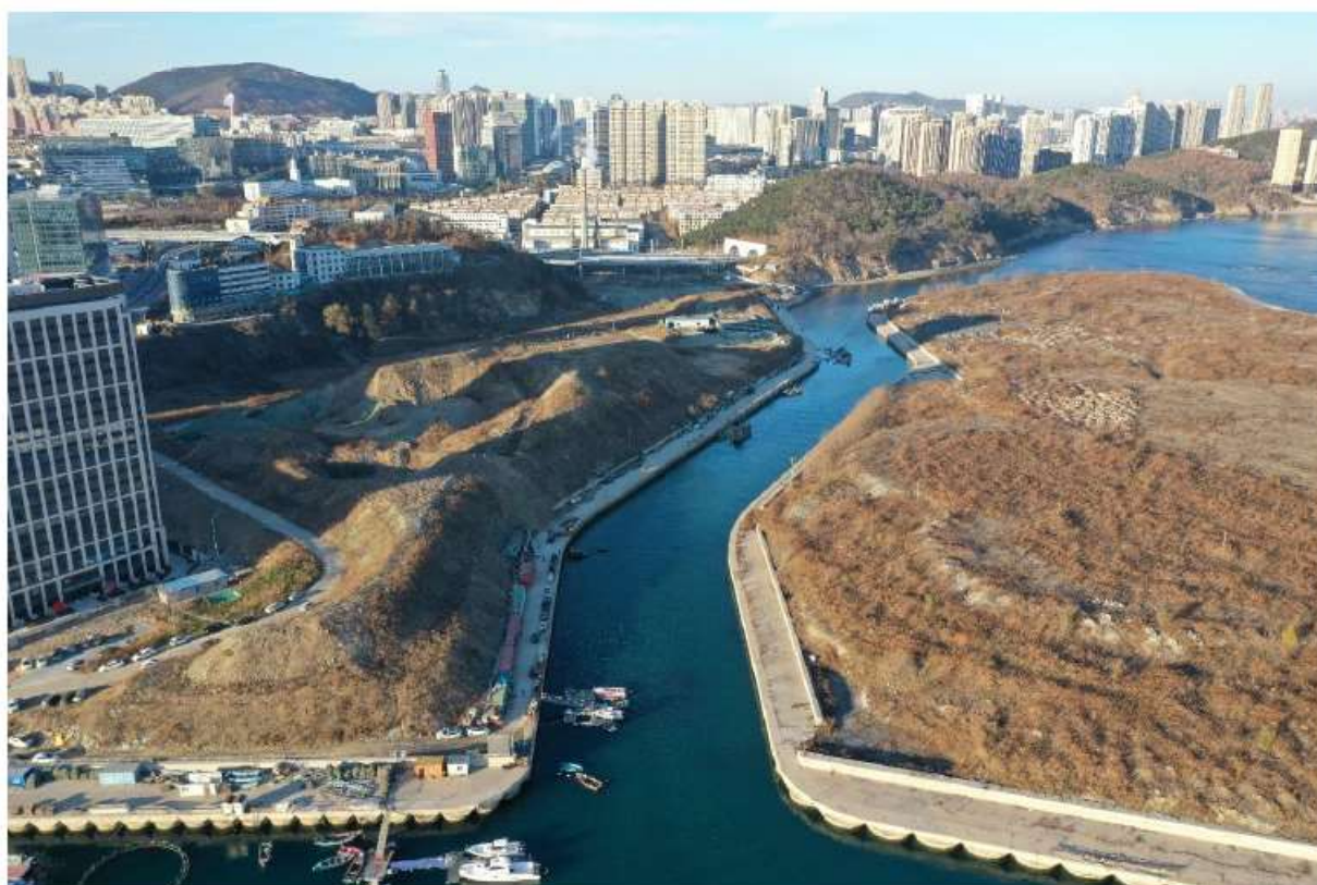
图 2.3.1-5 水道现状实景图
