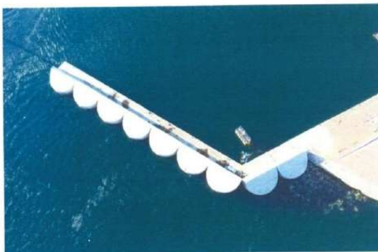
北防波堤俯拍实景照片
