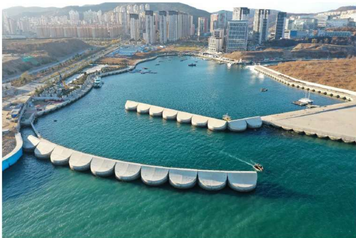
图 2.3.1-2 防波堤现状航拍实景图
